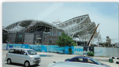
先日訪問したインドネシアで建設中の国際空港
