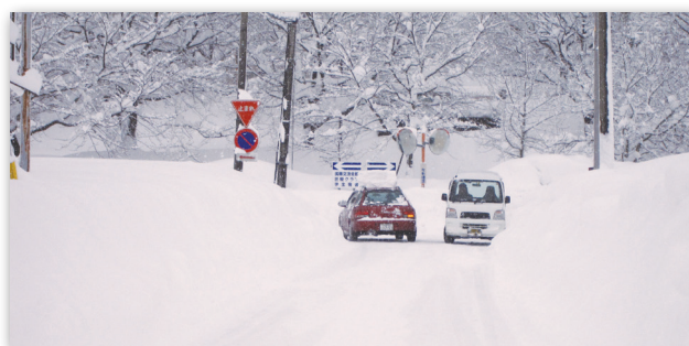
消雪パイプの設置前：道幅が狭く、圧雪になっている。（積雪時）
